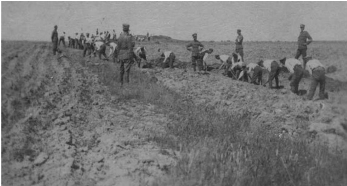
Εικόνα 2: Σκάψιμο για τη χάραξη των δρόμων της Νέας Ορεστιάδας από την ΧΙ Διλοχία Στρατού τον Ιούλιο του 1923- πηγή Ιστορικό και Λαογραφικό Μουσείο.
